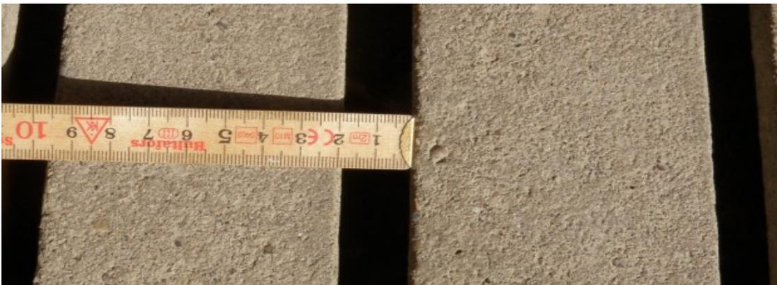
Wird anlässlich einer Kontrolle festgestellt, dass die Spaltenbreiten mehr als 18 mm aufweisen, führt dies zu Sanktionen und zudem werden verwaltungsrechtliche Massnahmen in Form einer kostenpflichtigen Verfügung angeordnet. Dies führt zu Mehrkosten und die Böden müssen so oder so ausgewechselt werden.
